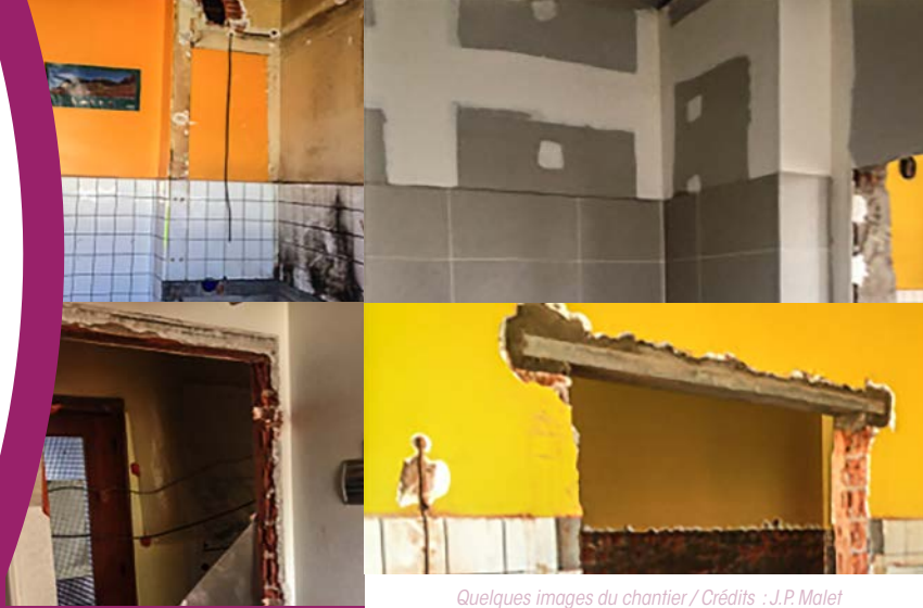
Quelques images du chantier / Crédits : J.P. Malet
